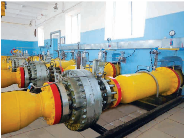
Регулятор давления газа, собранный в технологическую линию на заводской раме с нанесением антикоррозионного покрытия
