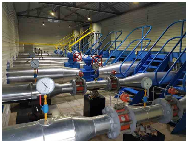
Объект до замены оборудования
