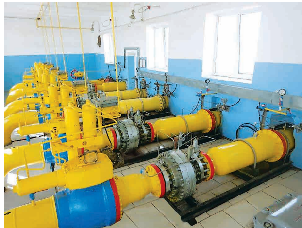
Регулятор давления газа, собранный в технологическую линию на заводской раме с нанесением антикоррозионного покрытия
