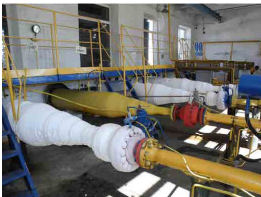
Объект до замены оборудования
