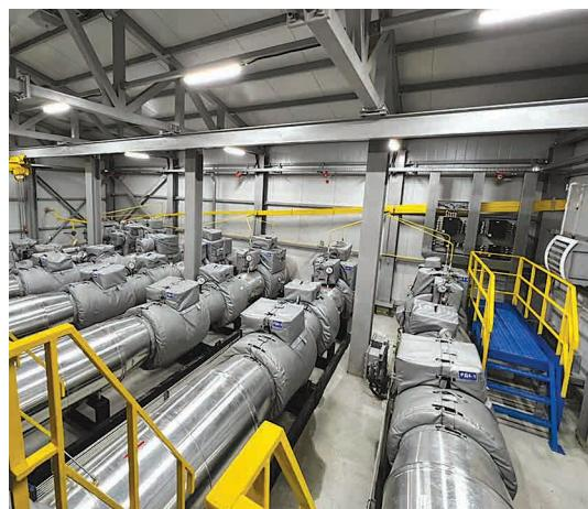
**Задача Заказчика:** Устранить проблему шумового загрязнения при работе технологического оборудования внутри КРП (более 110 дБА), а также обеспечить нормативные показатели по уровню шума ≤ 80 дБА, согласно нормативу СТО ПАО «Газпром», на объекте с максимальной пропускной способностью каждой линии 385 836 нм<sup>3</sup>/ч, Q<sub>max</sub> = 1.4 млн. нм<sup>3</sup>/ч.
